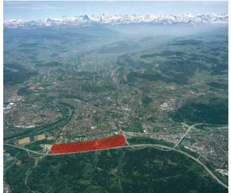
Superficie marquée en rouge: Défricher toute une partie de la forêt pour y construire des habitations? Impensable! La forêt suisse est strictement protégée par la loi fédérale sur les forêts.
